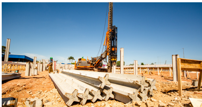
Instalação das Estacas Estrela com Martelo Hidráulico
