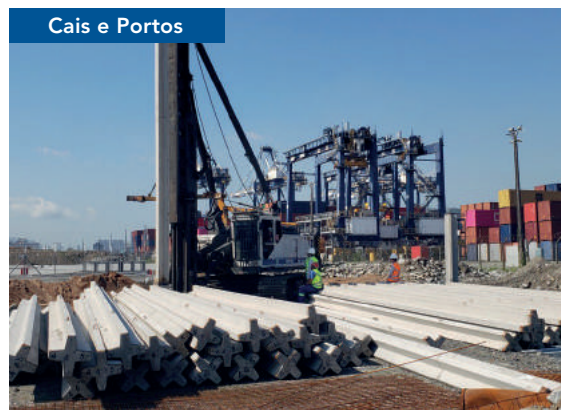
Terminal de carga
